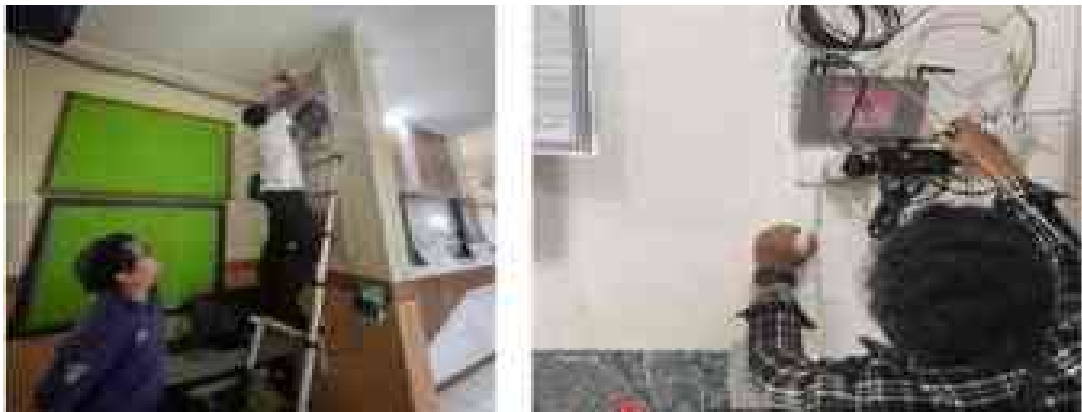
Pergantian perangkat Cisco dari seri lama mx65 ke seri baru mx68 di puskesmas mengwi 2, tumbak bayuh Pemasangan perangkat MX68W di pustu dalung permai
